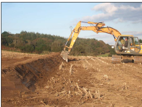
Photo : construction de talus avec pelle à chenille _ campagne 2010 IRVILLAC
