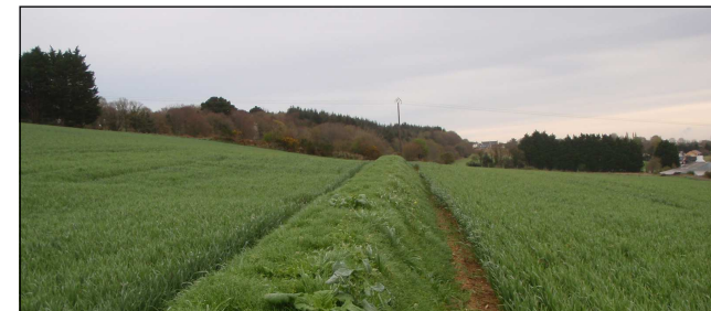
Photo : construction de talus antiérosif _ campagne 2010 IRVILLAC
